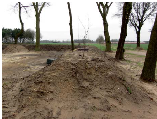
Neuanlage einer Wallhecke: Wallkörper modelliert und bepflanzt
