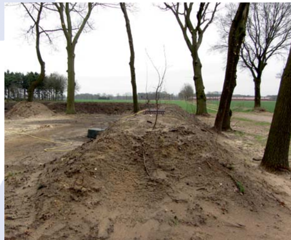
Neuanlage einer Wallhecke: Wallkörper modelliert und bepflanzt
