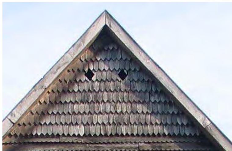
Giebel mit Holzschindeln
