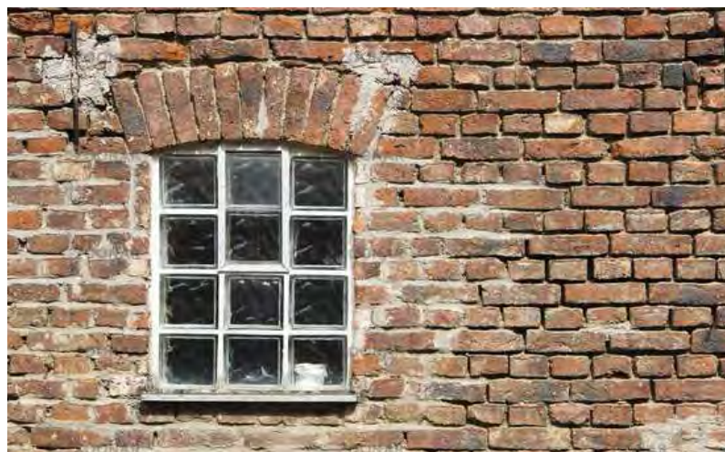
Glasbausteine im Mauerwerk
