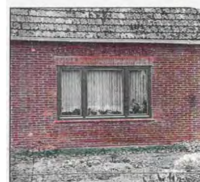
Alternative: Beibehaltung der ursprünglichen Mauerwerksöffnungen / neue Fenster mit Oberlicht
